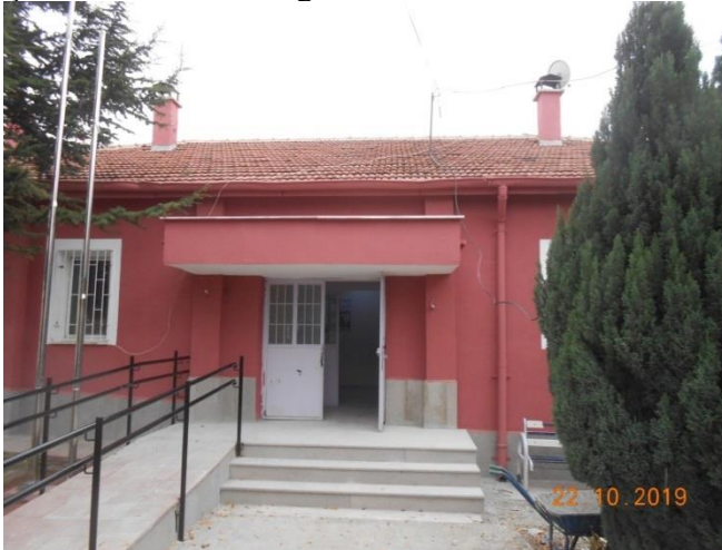
Çobanlar Kocaöz Sağlık Evi Bakım Onarım
