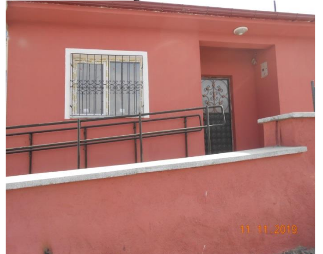
Sandıklı Kusura Sağlık Evi Bakım Onarım
